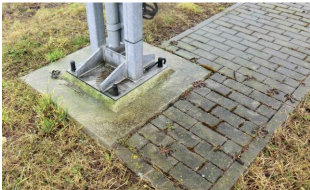
Abbildung 5: Mastfuß (Bestand, Beispiel 2)
