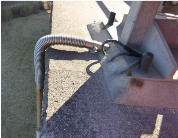
Abbildung 6: Mastfuß (Bestand, Beispiel 3)
