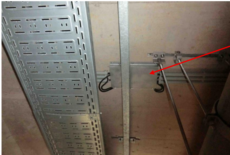
Abbildung 3: Standort 3 – Kabelabdeckung im Brückenhohlkasten
